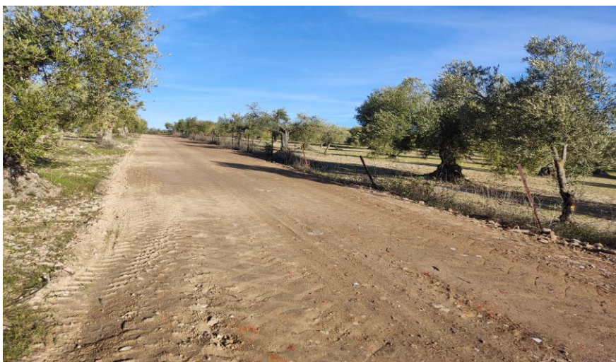
Ilustración 10. Aplicación de árido reciclado en un camino rural.
